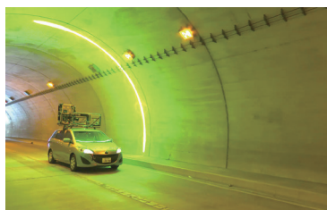
トンネル内部の撮影の様子
