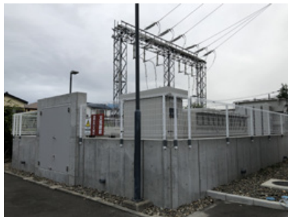
特高変電所 擁壁設置(RTC)
