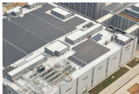
写真2 屋上に設置された太陽光パネル
