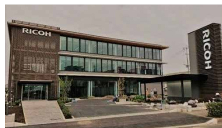
熊本支社 Nearly ZEB
