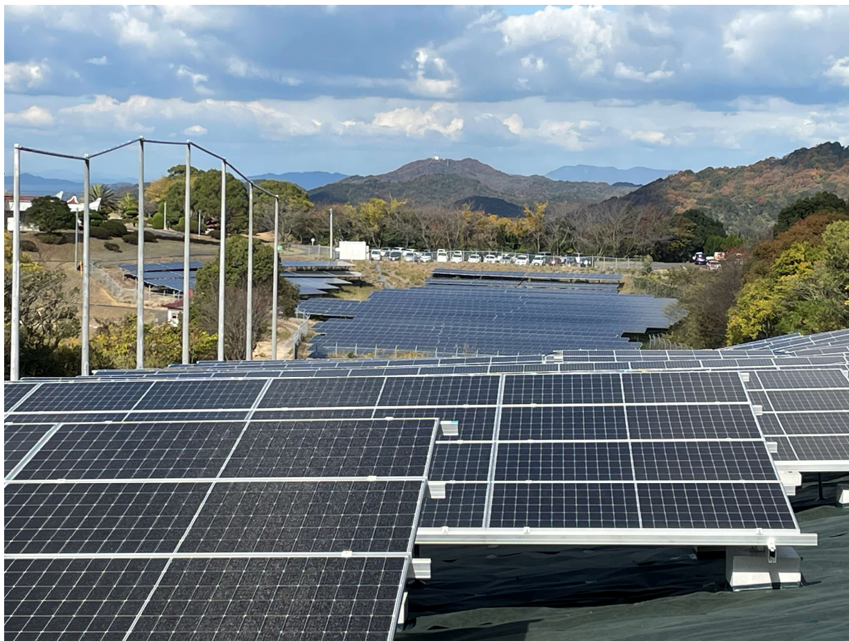
香川県さぬき市に設計、施工中の太陽光発電設備
