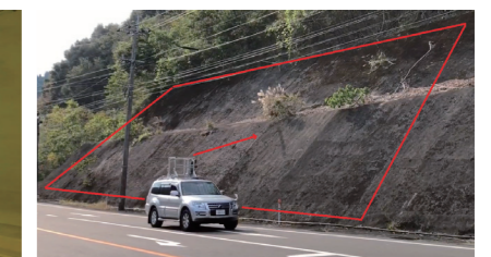
斜面・のり面の撮影イメージ
