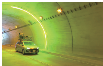
トンネル内部の撮影の様子
