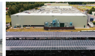
RE100を達成済みの英国工場の自家発電設備
