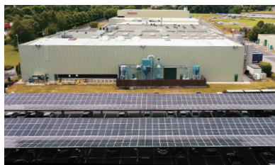
RE100を達成済みの英国工場の自家発電設備
