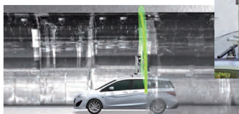
往復で走行するだけでトンネルの全覆工面を撮影
