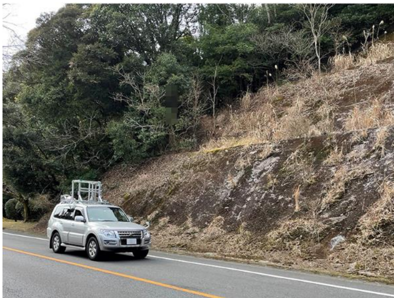
<のり面モニタリングの様子>
