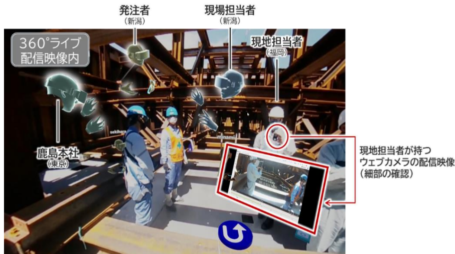
360°ライブ配信映像とウェブカメラ映像を併用して、遠隔立会検査を実施
