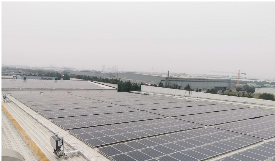
Ricoh Thermal Media (Wuxi) Co., Ltd. 社屋屋上
