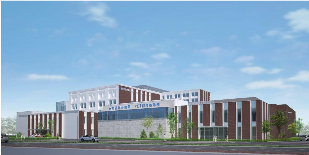
熊谷総合病院 PET 総合検診棟
