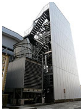
溶剤のクローズドリサイクルが行われている施設(蒸留棟)
