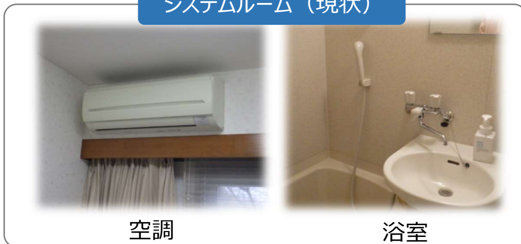
システムルーム（現状）
