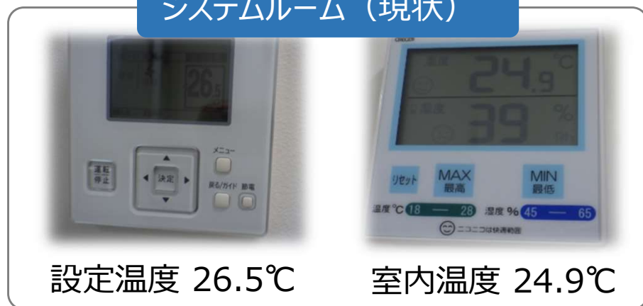
システムルーム（現状）
