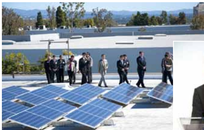
式典後、屋上に設置された太陽光発電システムの見学会が行われました。
