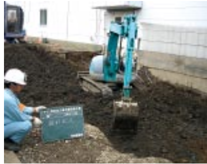
リコーテクノロジーセンターの土壌改良工事の様子
