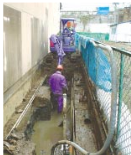
事業用借用地の土壌改良工事
