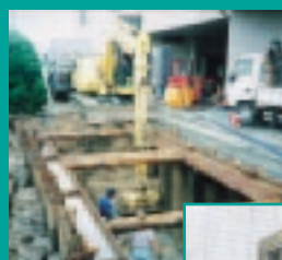
土壌掘削除去工事例 (リコー計器)
