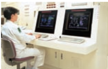
リコーやしろ工場の安全監視コントロールルーム
