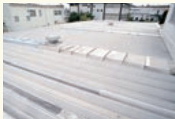
断熱塗装を施した工場の屋根
