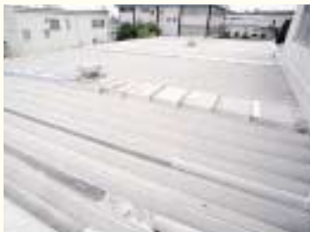
断熱塗装を施した工場の屋根
