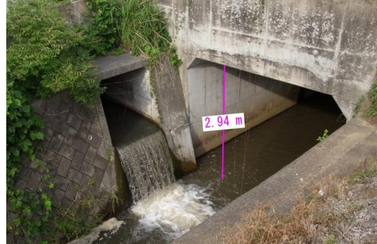
橋梁の高さを測定 (1点と面の最短距離)
